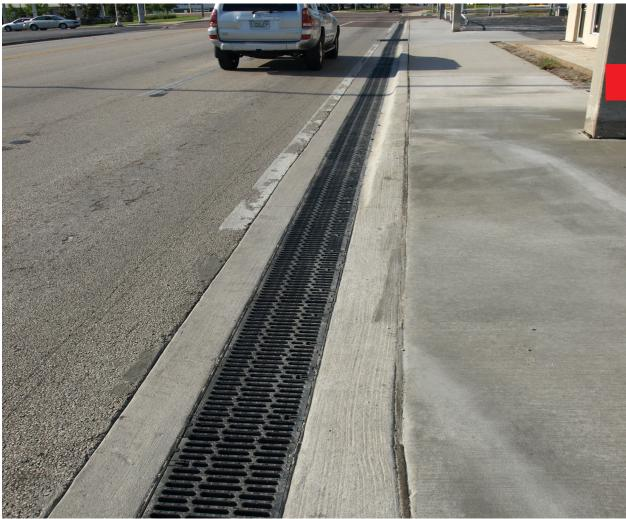
ACO Drain<sup>®</sup> PowerDrain<sup>®</sup> S300K Slotted Ductile Iron Grates acoswm.com/drain/powerdrain
